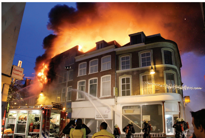
Foto 5: Uitslaande brand uit het dak in de loop van de avond (foto A. Kappers, GPTV)
