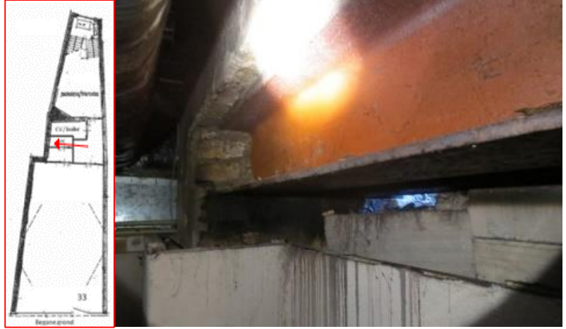
Foto 14 ,latei ter plaatse van dichtgezette doorgang naar Kelders 31.
