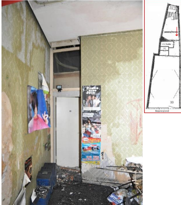
Foto 20, verbinding van bergruimte naar kapsalon. Onder het plafond is een open constructie aanwezig.
