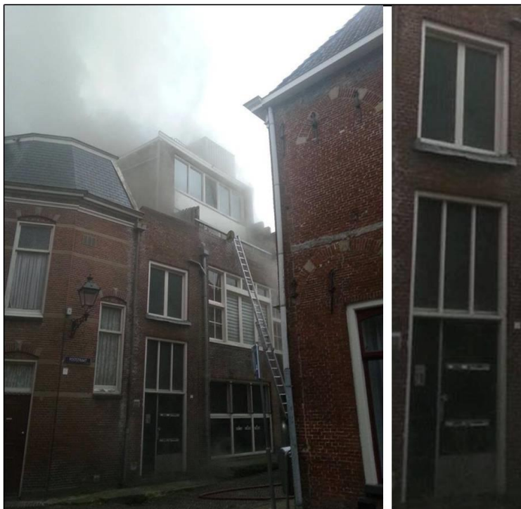
Foto 6, donkere rook voor ramen trappenhuis, rookverspreiding onder voordeur door.
