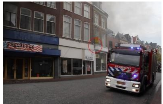
Foto 9, Aankomst eerste eenheid ± 17:29 uur. Rook zichtbaar bij Kelders 33 aan de zijde van Kelders 35.
