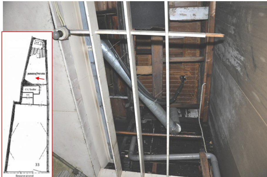
Foto 28, ruimte boven bergruimte. Metalen toevoer kanaal komt uit op plat dak.
