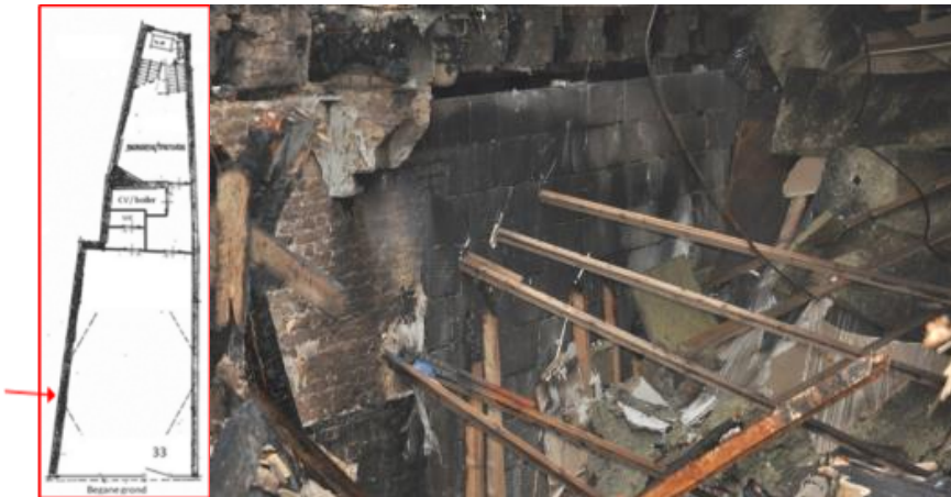
Foto 15 ,dichtgezette doorgang voorzijde aan zijde Kelders 31
