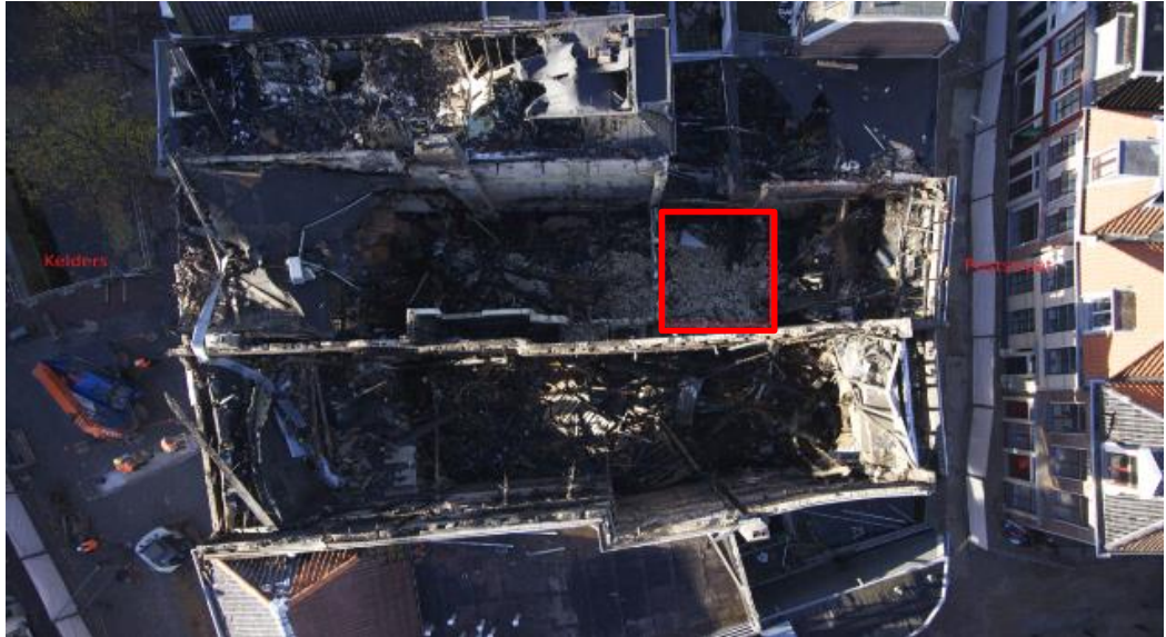
Foto 4, Bron: internet. Bovenaanzicht, rode kader is globaal de plaats van het platte dak weergegeven waar de brand doorgeslagen is. Links is de Kelders en rechts de Poststraat.
