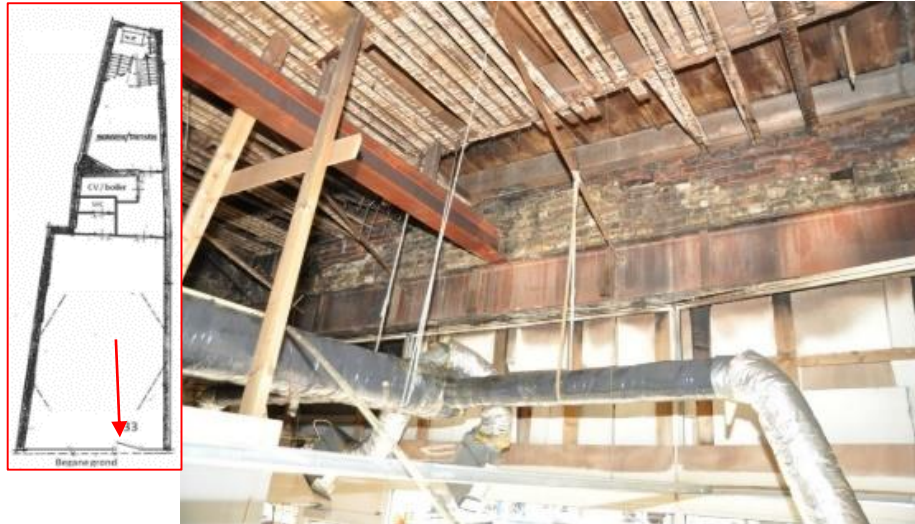
Foto 10, gevelconstructie Kelders 33 van binnen gezien (gedeelte boven ramen zichtbaar).
