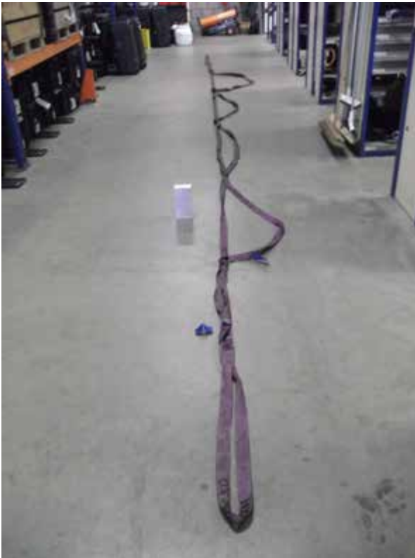
Foto 1: Hijsstropen niet gelijkdragend aan wal
